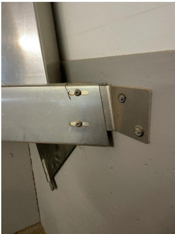
Sätt fast nedtill med de 2 väggfästena
